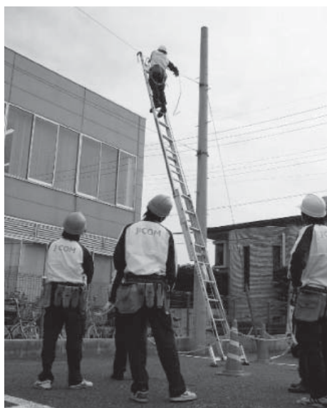
図10 集合研修—引込工事実習—
